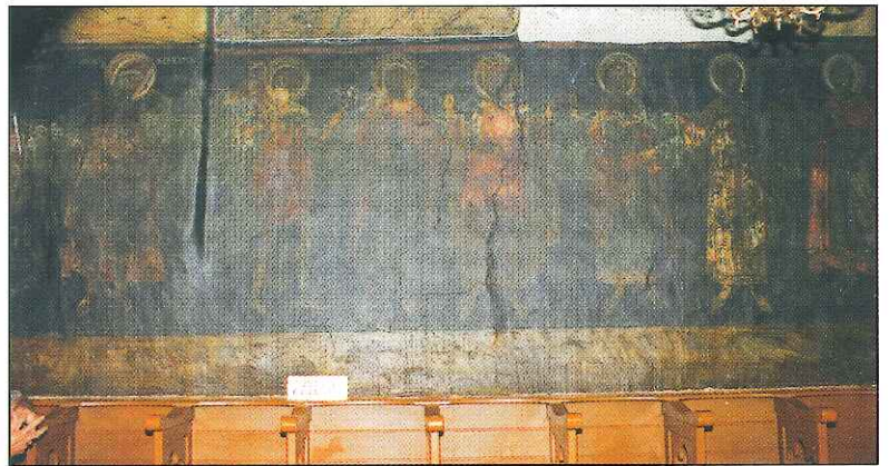
Γρεβνίτι. Ι.Ν. Κοιμήσεως Θεοτόκου. Τοιχογραφίες βόρειας πλευράς. Διακρίνονται οι μεταβολές στη ζωγραφική τις οποίες έχουν επιφέρει οι επεμβάσεις του Τάτση, καθώς και το παχύ στρώμα του οξειδωμένου βερνικιού με το οποίο κάλυψε τις επιφάνειες.
