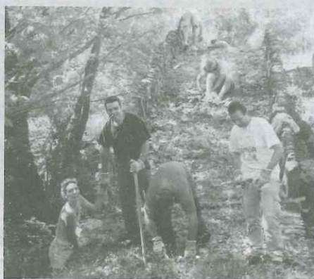
Το ΠΡΙΝ του γεφυριού “Καλντερούσας”
